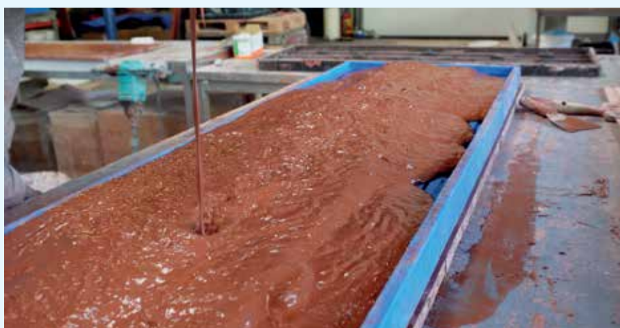
In de fabriek in Nieuwerkerk aan den IJssel worden de panelen gemaakt door het minerale materiaal in een mal te gieten.
